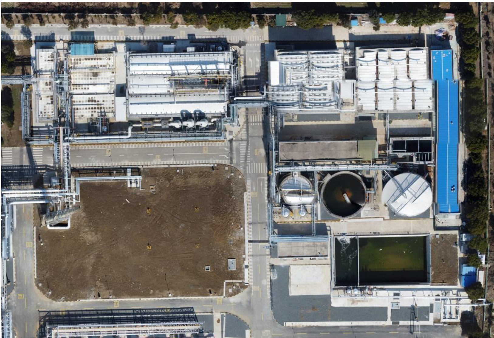
图 4.1-4 废水处理站航拍图
