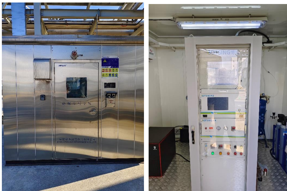
图 4.2-2 烟气在线监测装置
