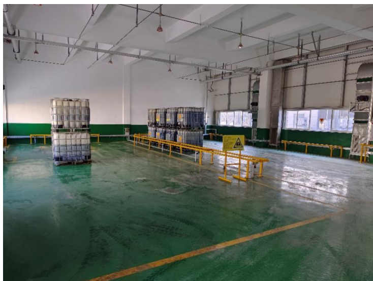
图 4.1-12 危废库内部及地面防渗情况
