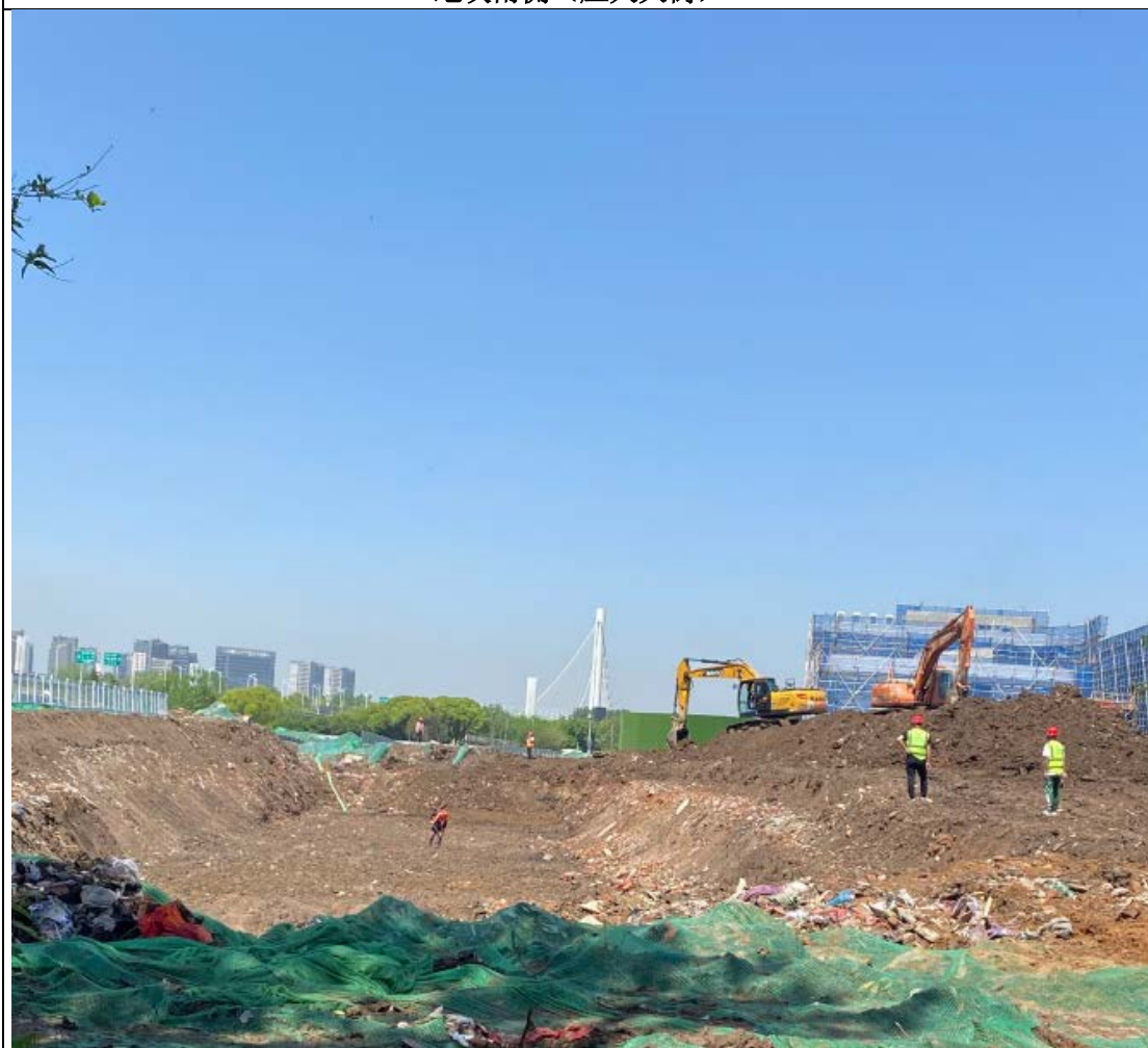
地块北侧（在建道路）
