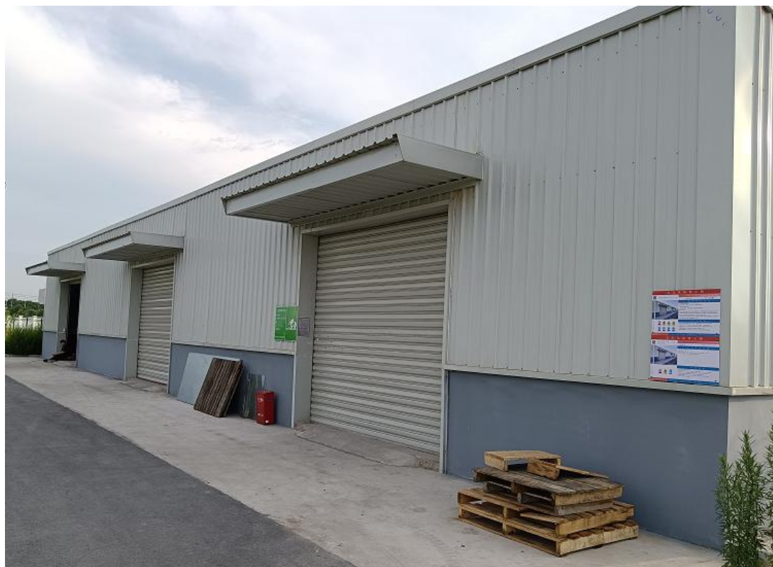
图 7-2 一般固废仓库区
