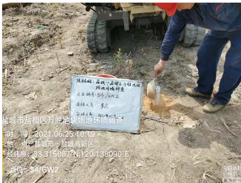
图 5-8 地下水监测井填充滤料与止水材料
