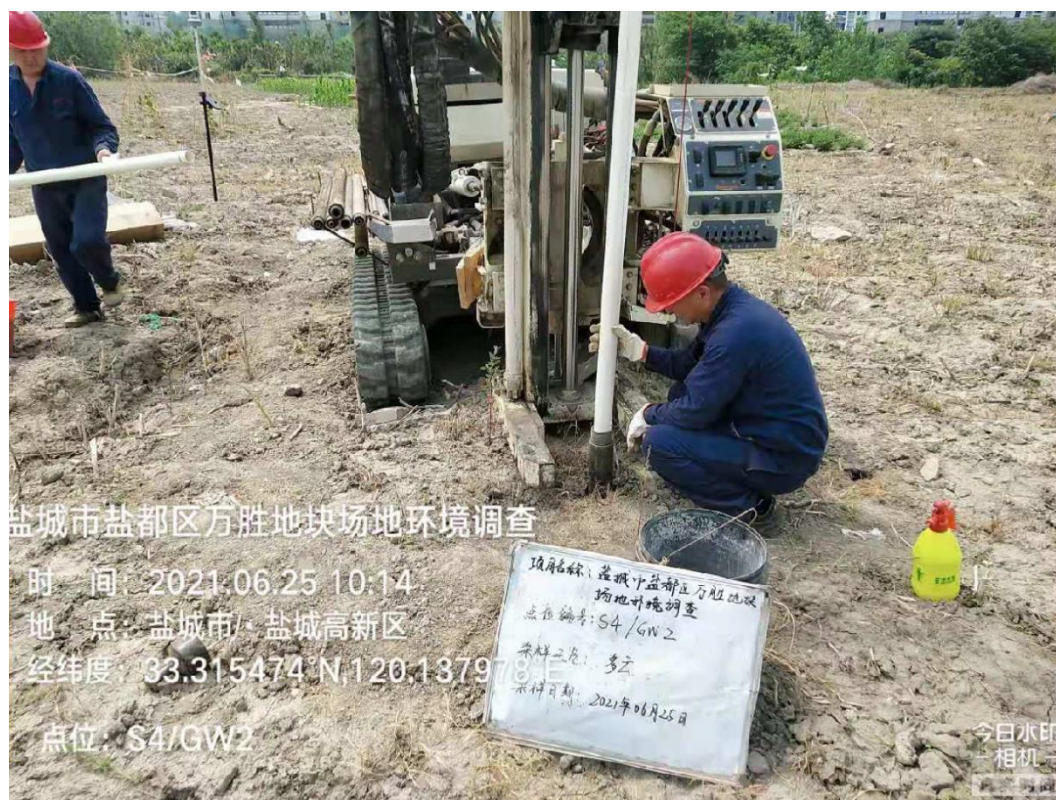
图 5-7 地下水监测井下管（白管）
