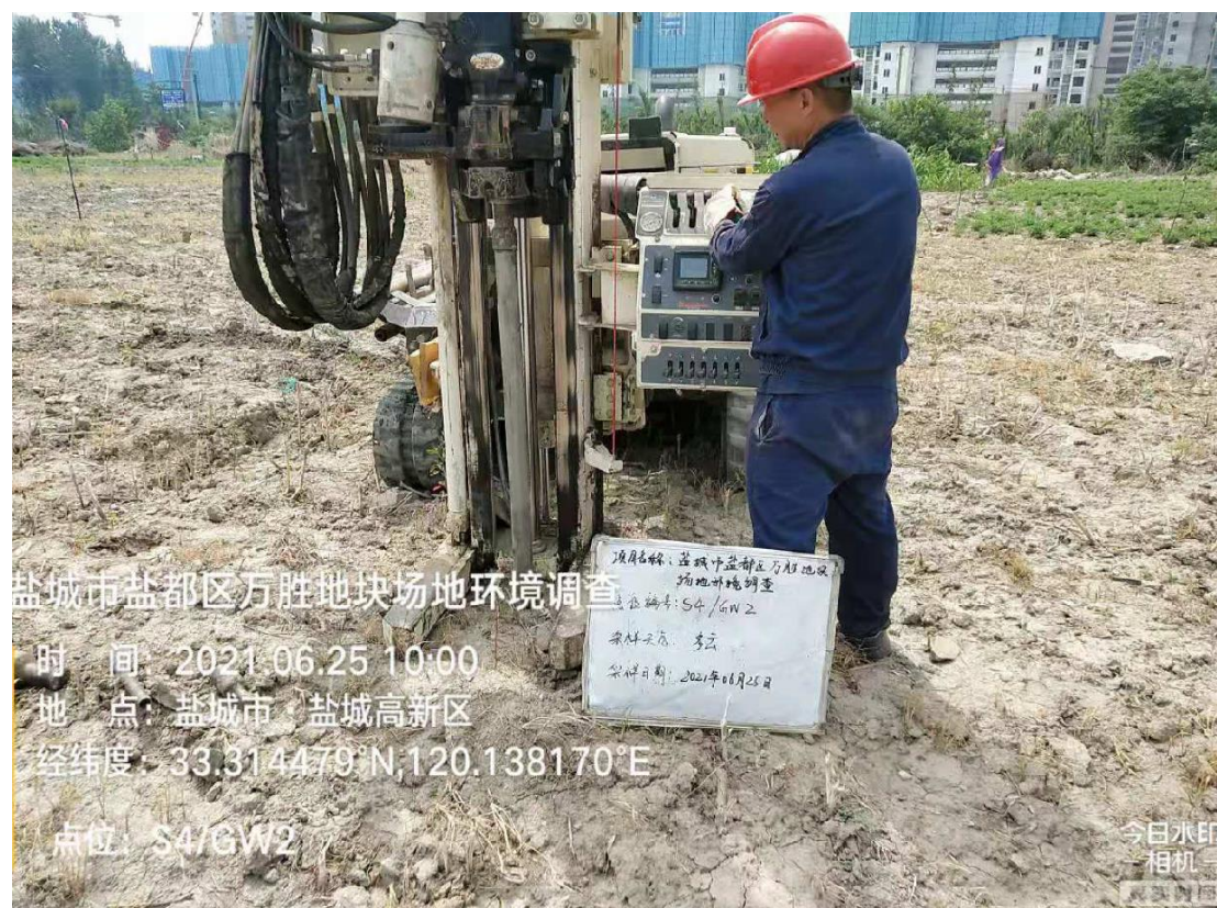
图 5-6 地下水监测井钻孔现场
