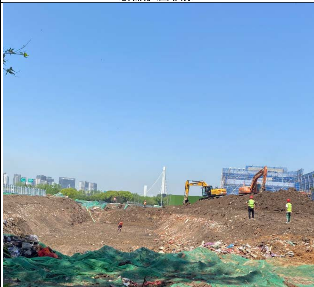
地块北侧（在建道路）
